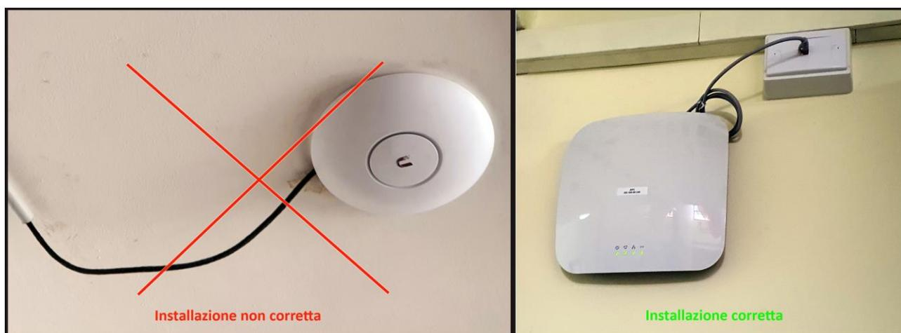
Figura 10 – Installazione corretta dell'Access Point
